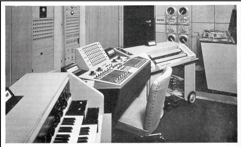
Abbildung 5: Generatoren und Formungsmittel im elektronischen Studio des NWDR in Köln (1954); links vorn Bode-Melochord, in der Mitte das Schalt- und Steuerpult, rechts daneben ein elektronisches Monochord nach Trautwein, im Hintergrund (rechts) diverse Informationsspeicher (Quelle: Enkel, 1954, S. 14)
